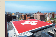
屋上ヘリポート
