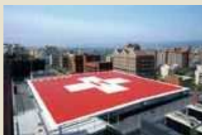
屋上ヘリポート
